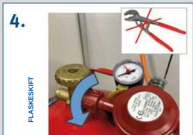
Spænd trykregulatoren med hånden – drej mod uret, brug ikke tang
